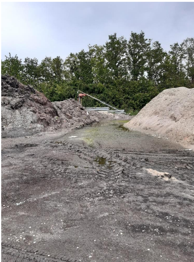
Til højre i billedet ses oplag af sand på deponiområde øst.
