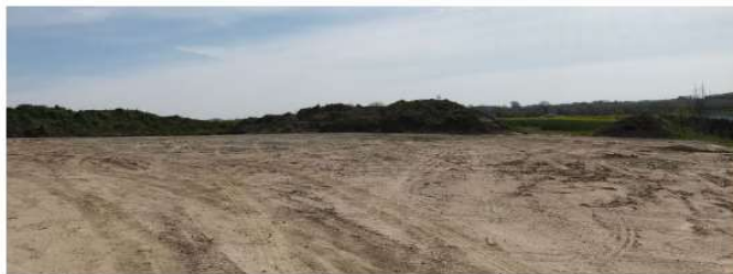
Arealet er reetableret, og afventer opstart august 2023
