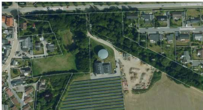
Det eksisterende mellemdepot øst for solcelleanlægget i Broager
