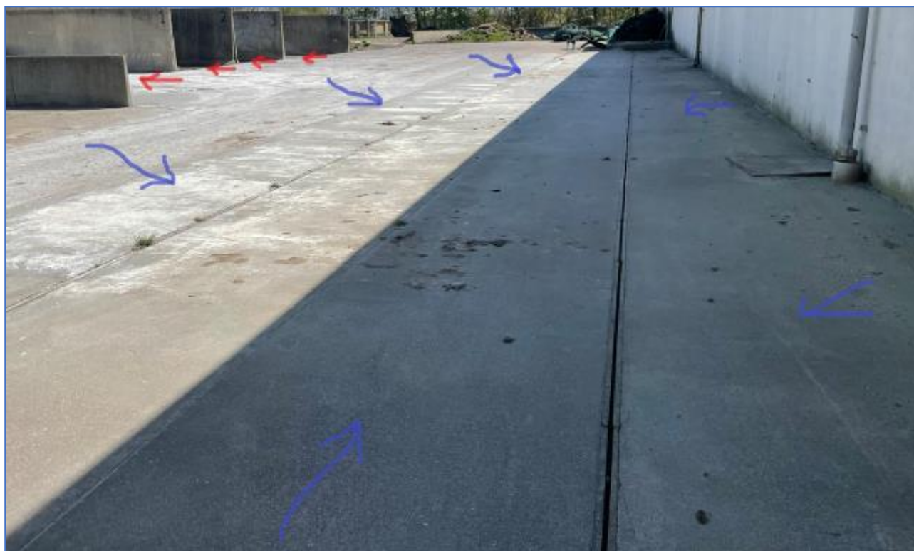
Figur 14, fald på kalve- og ensilageplads. Foto: Landbosyd
