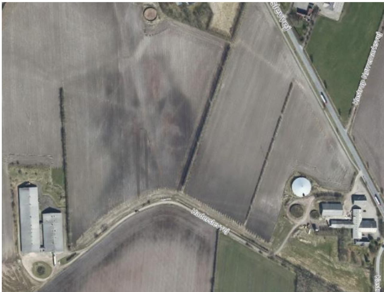
Figur 1. Oversigt over bygninger og gyllebeholdere.
