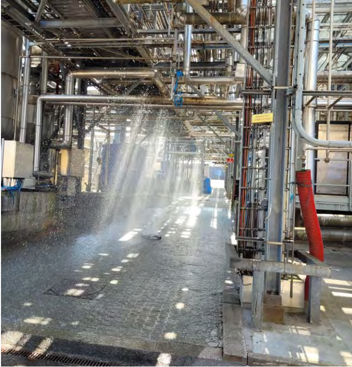
Figur 3: Vandingsområde under rørbro
