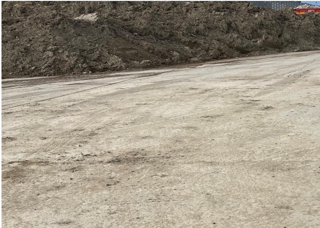
Impermeabel belægning (beton) med fald mod kloakbrønde, der er tilsluttet 2 sandfang og olieudskiller for afledning af overfladevand.
