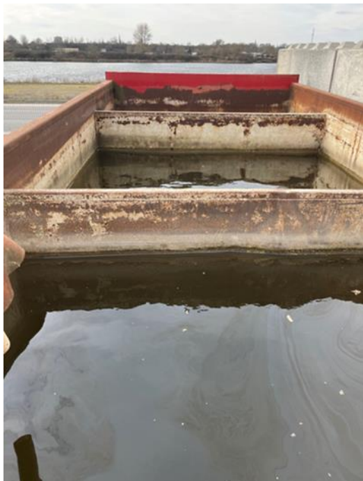
1. trin i vandrenseanlæg. Separationsanlæg (skillekasser)
