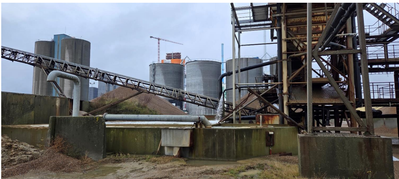
Skyllleanlæg med stort vandbassin, hvor en stor del af vandet recirkuleres.
