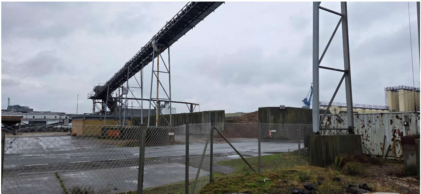
Losset stenmateriale transporteres med dette transportbånd fra kajpladsen vest for virksomheden til råvarelagre på modsatte side af Oliehavnsvej.
