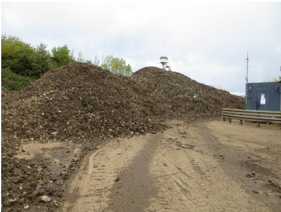
Efterbehandlet shredderaffald oplag på kanten af belægningen ved støjvæg
