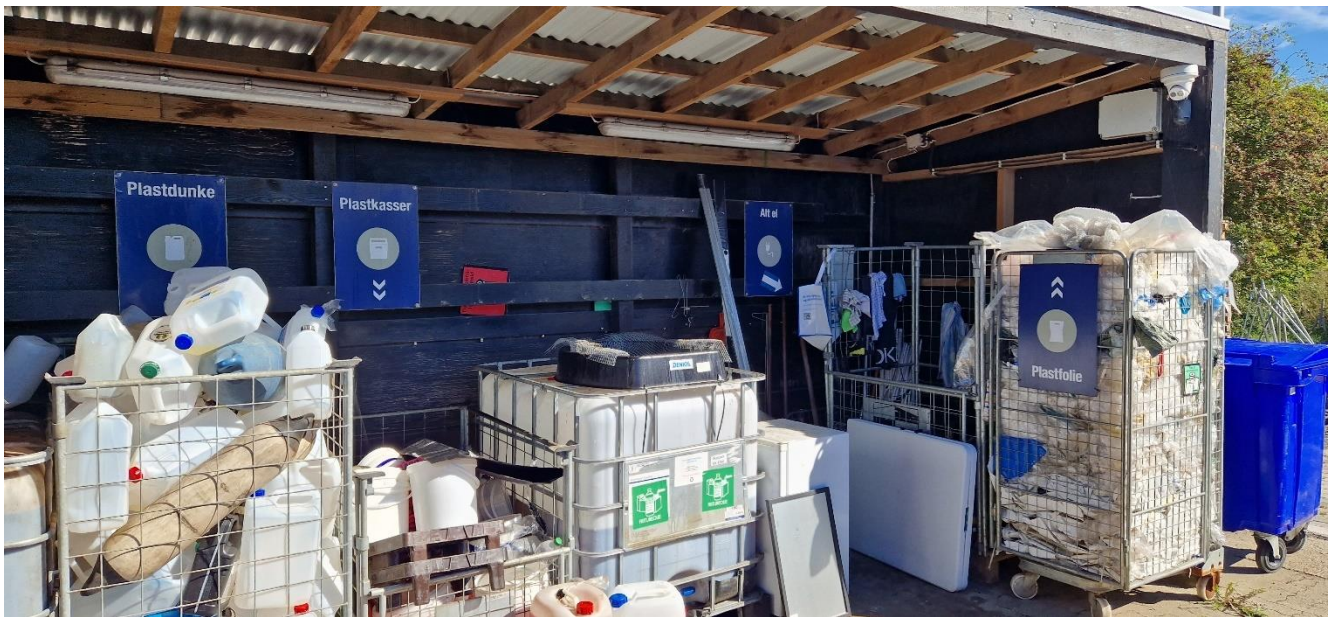
Affaldsgården, som er delvist overdækket og belagt med sf-sten med plastmembran under.
