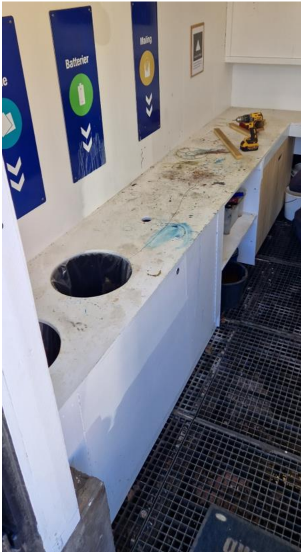
Miljøstationen er indvendigt indrettet med sump til opsamling af evt. spild.
