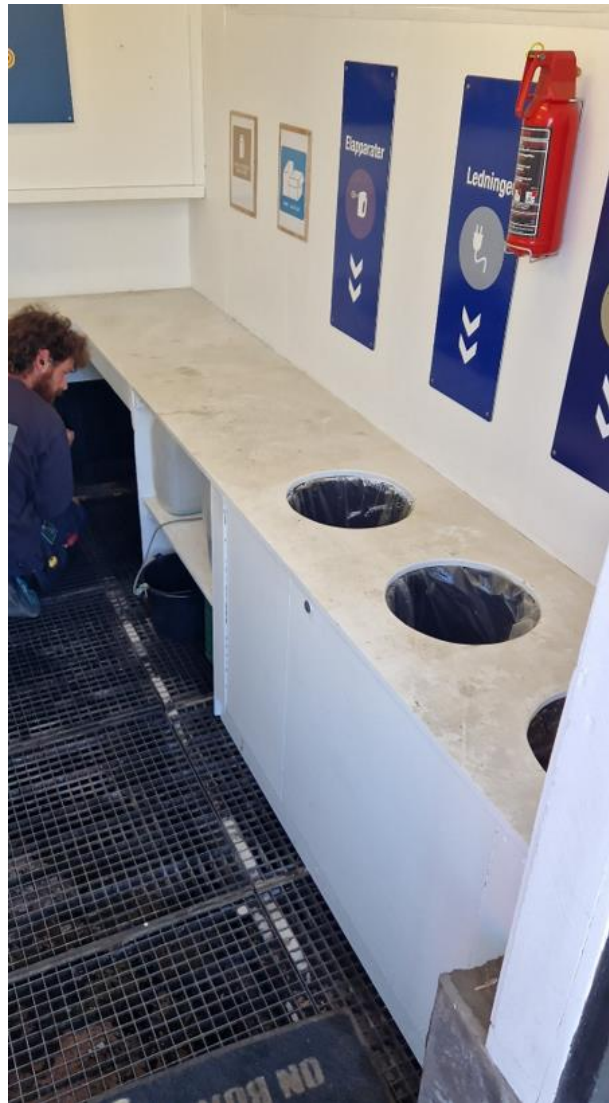
Miljøstationen er indvendigt indrettet med sump til opsamling af evt. spild.
