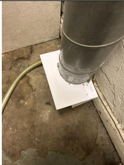
Figur 4: Test af udsugning med A4-papir.
