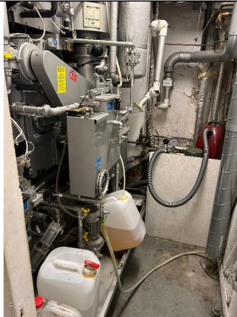
Figur 3: Bagsiden af resemaskine og produkter på spildbakke.
