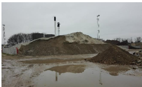
Knust beton, kvaliteten er fin.
