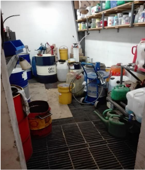
Rum med opbevaring af farligt affald, olier mv. Kapacitet under rist.
