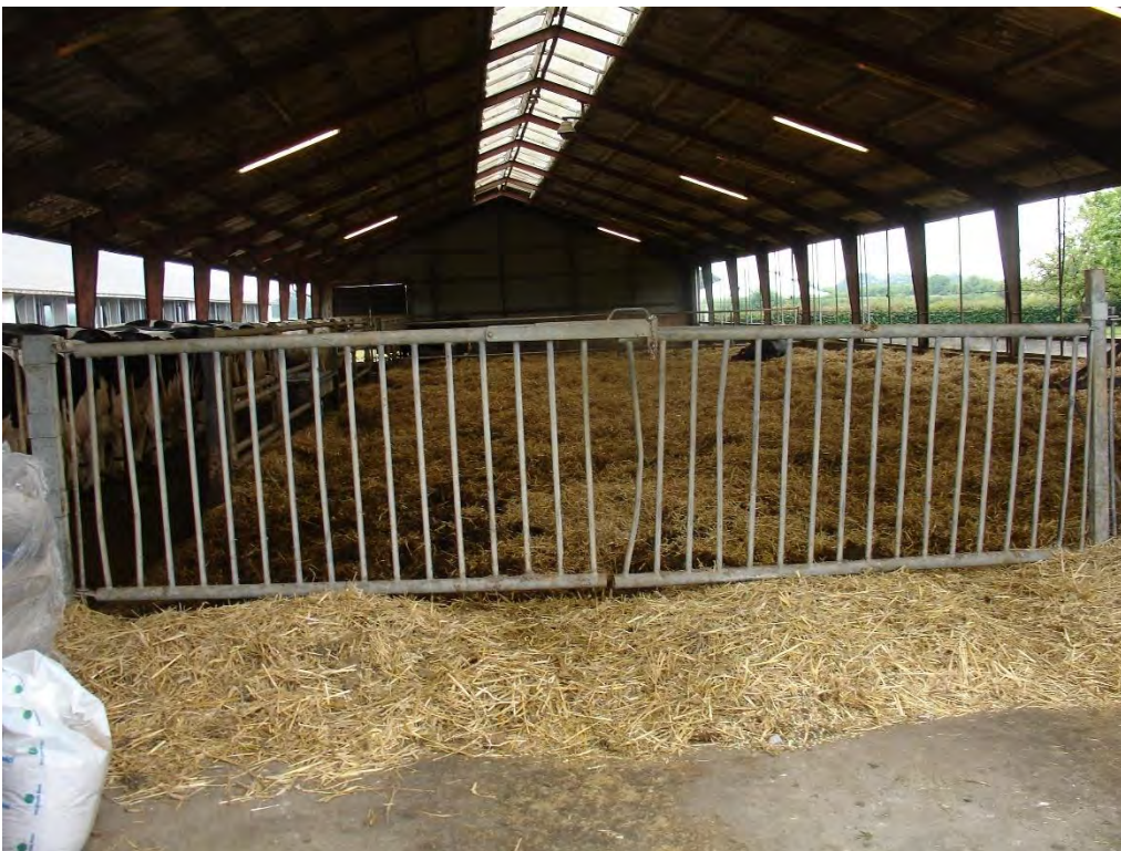
Fig. 2 Kælvningsstald, der ombygges til sengestald. Foto: LandboSyd
