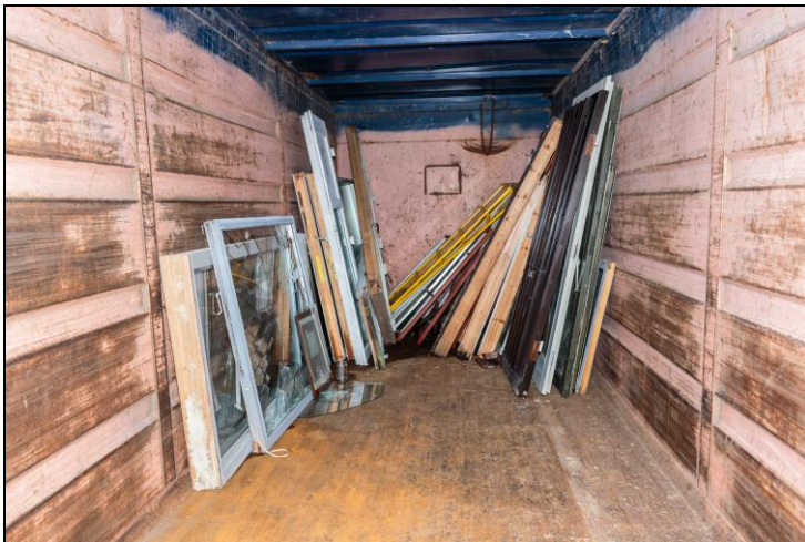
Foto 1 Opbevaring, i lukket container, af potentielt PCB-holdige vinduesrammer med glas.
