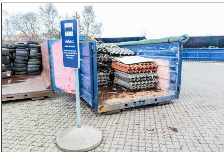
Foto 4 Opbevaring af potentielt asbest-holdige materialer.
