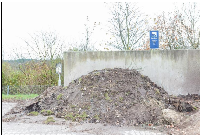
Foto 3 Opbevaring af jord på befæstet areal (belægningssten).
