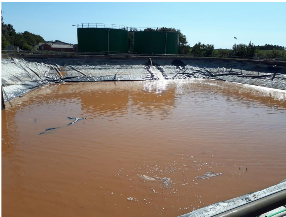
Tilførsel af spildevand til bassin 2
