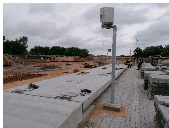
Vægt under etablering
