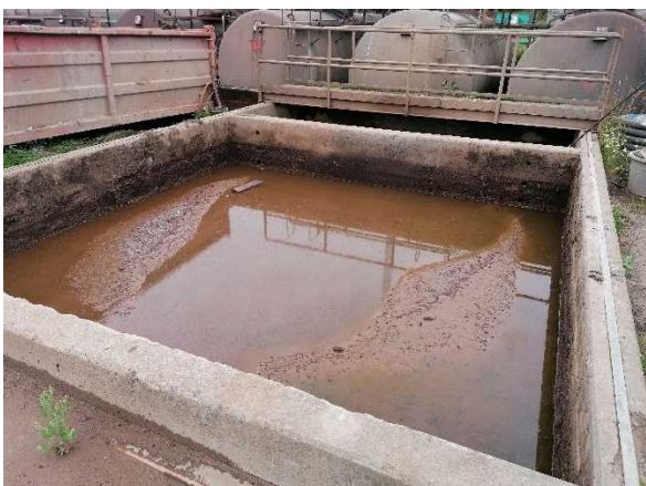
Afvanding af kloakslam
