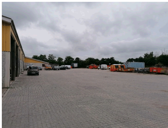
Ny flisebelægning på store arealer
