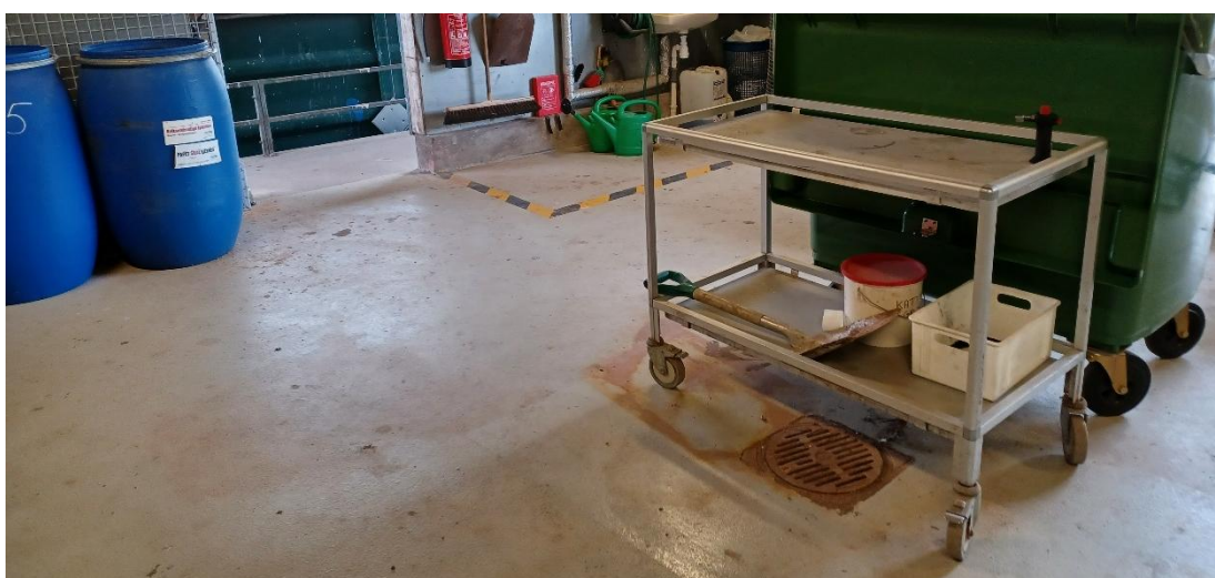
Figur 2. Rum til farligt affald. Øverst: Spildbakke til omhædling af spildolie. Midterst tv: Blå tønder og sæk med opsugningsmateriale. Midterst th: Tønde med opsugningsmateriale og kemi. Nederst: Gulv med afløb til sump.
