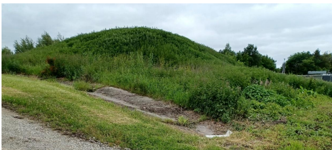
Figur 1. Efterbehandling af deponeringsanlægget. Øverst: Biocover på afdeling 4.1. Midterst: Markering af områder med deponeret asbest på afdeling 1B og 4.1. Jordoplæg placeret på afdeling 1B øst for gasbehandlingsanlægget.
