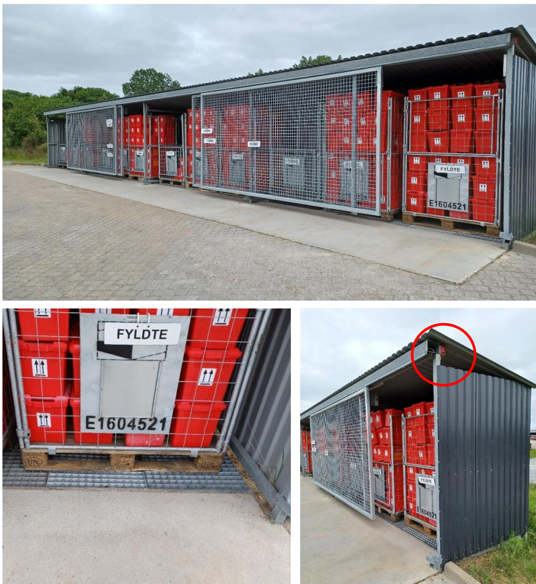
Figur 5. Oplag af miljøkasser. Øverst: Oplag af kasser i tremmebure. Nederst tv: Rist over sump. Nederst th: Lampe til alarm for spild til sump.
