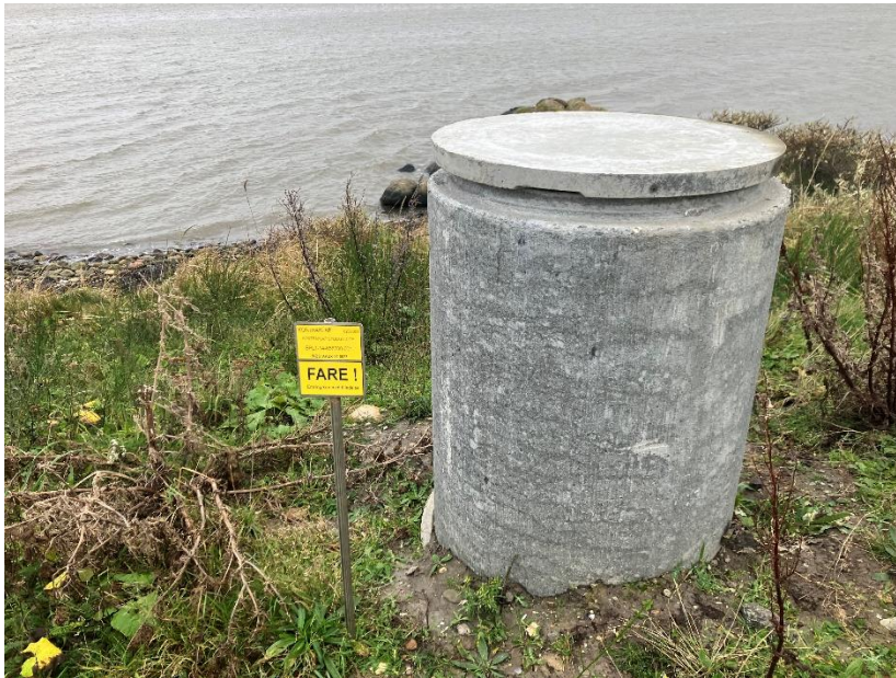
Foto 8. Brønd ved udløb af grøft mellem etape 2b og FCM's areal.
