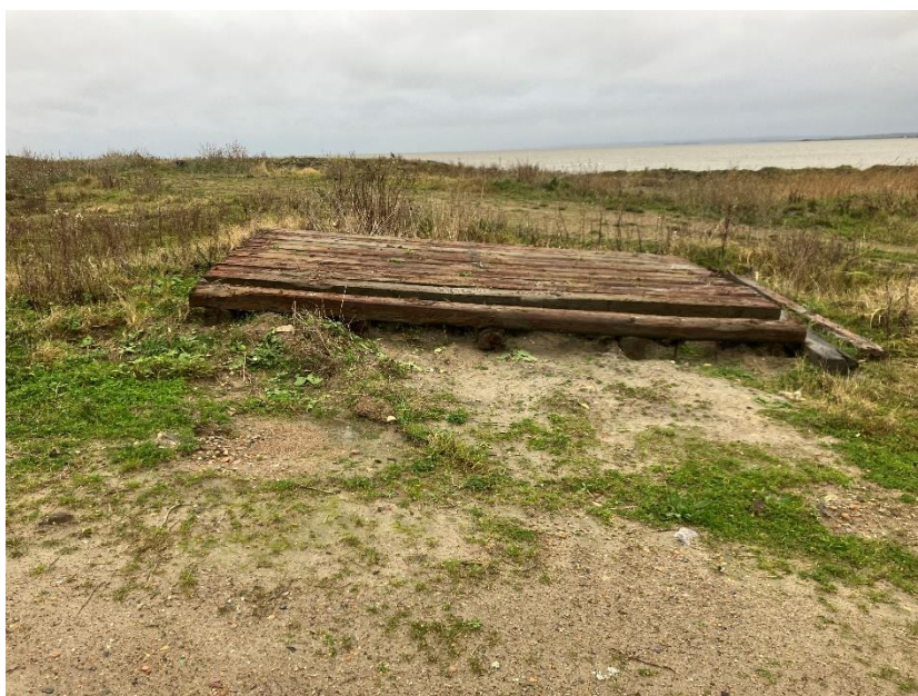
Foto 4. Kørerampe til aflæsning af sediment på sydlig del af etape 2b.
