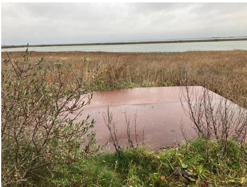
Foto 5. Kørerampe til aflæsning af sediment på nordlig del af etape 2b.
