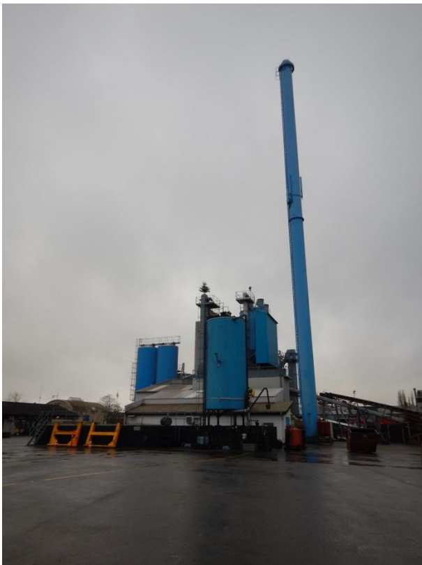
2. Produktionsanlægget set fra øst med 48 m højt afkast og bitumenemulsionstank i forgrunden.
