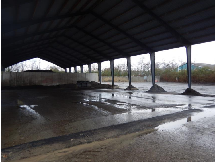
6. Hal til genbrugsasfalt.
