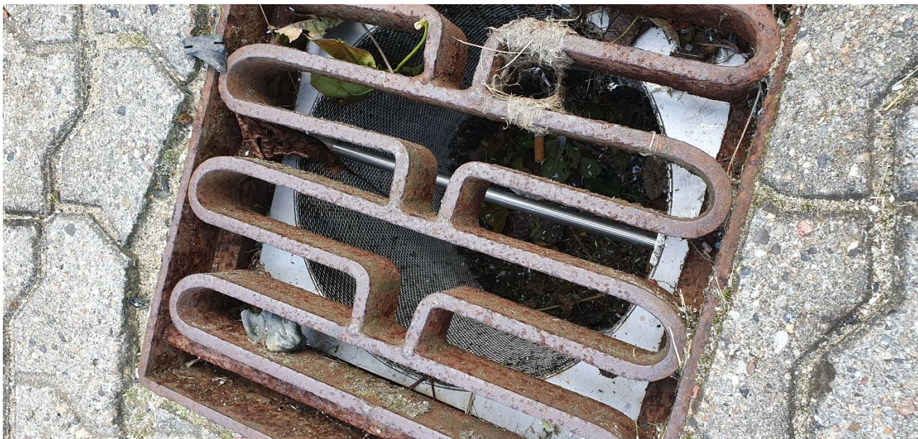
Rist er installeret i regnvandsbrønde.
