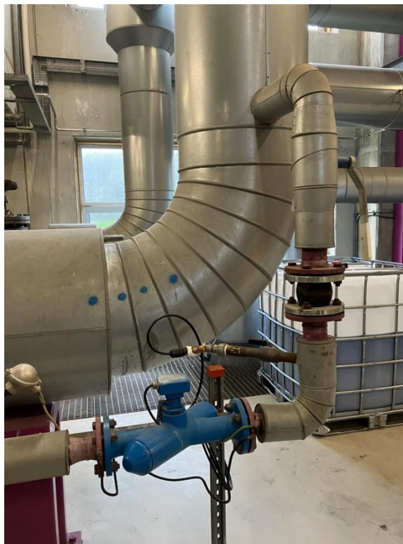
Billede D.2 NaOH dosering i fjernvarmesystem
