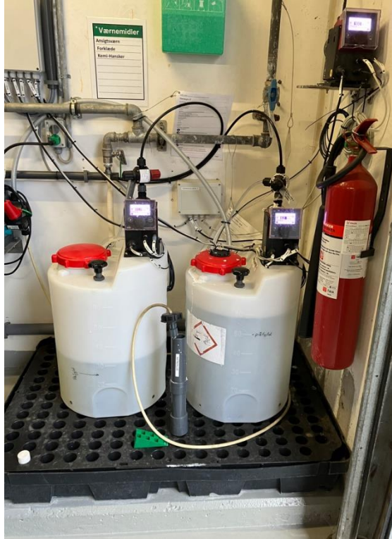
Billede D.1 Oplag af NaOH
