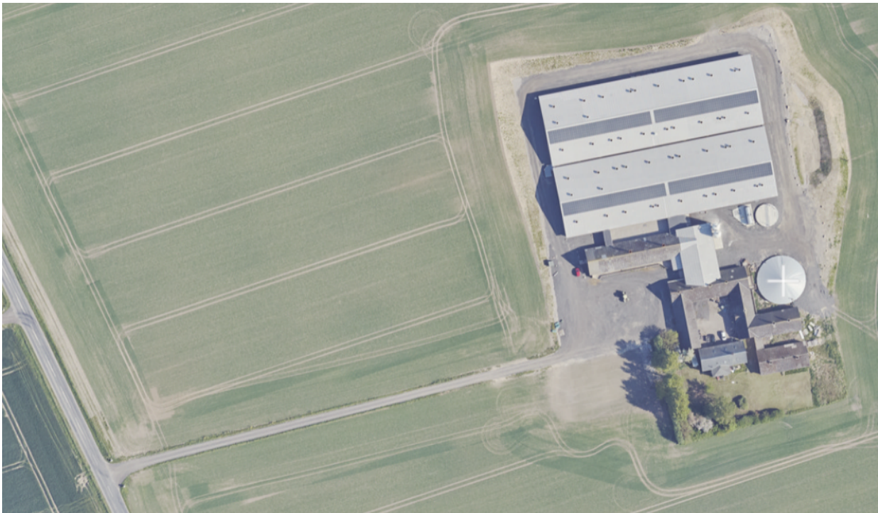
Luftfoto af gyllebeholder, hvorpå der er etableret teltoverdækning (markeret med kryds).
