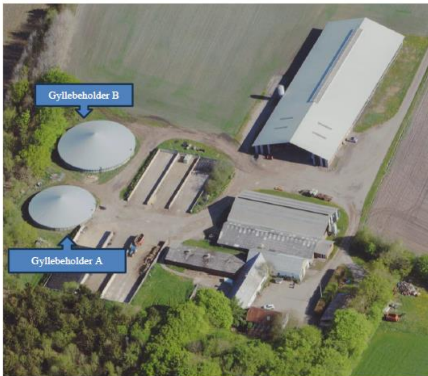
Figur 1. Placering af de to gyllebeholdere, som er teltoverdækket.
