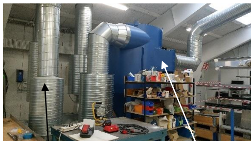
Billede nr. 1: Udsugningsanlæg for svejsning samt slibning og spåntagning
