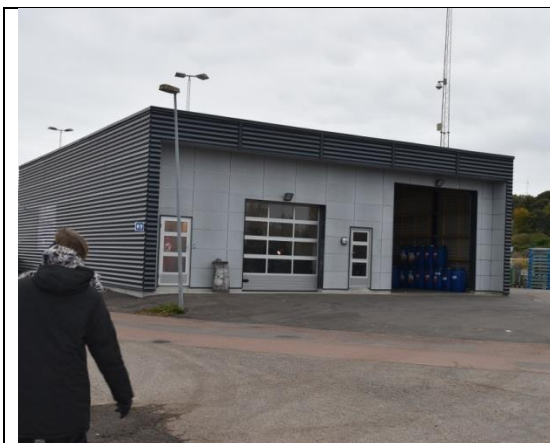
Ny bygning til miljøfarligt affald
