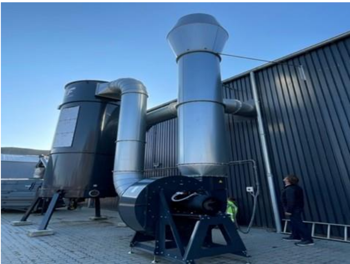
Figur 1: Afkast 1 fra hal 4, tilknyttet JKF filteranlæg.
