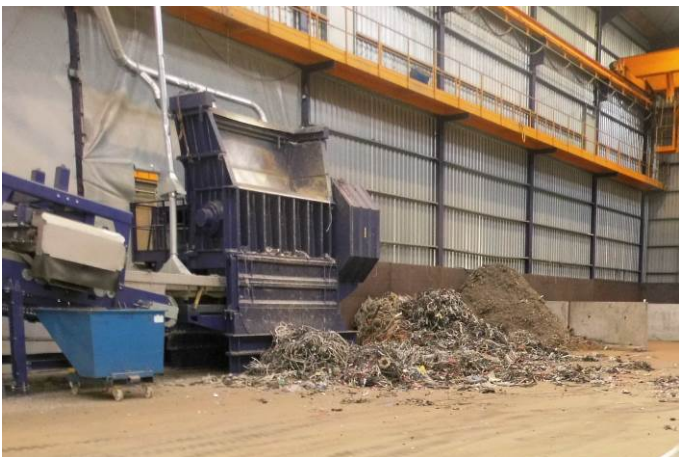
Start på kabelbehandling – fødekassen
