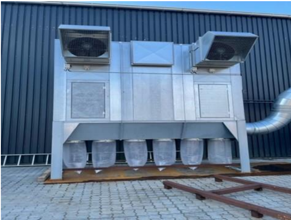
Figur 4: Afkast 2 fra hal 4, tilknyttet Aagaard filteranlæg.
