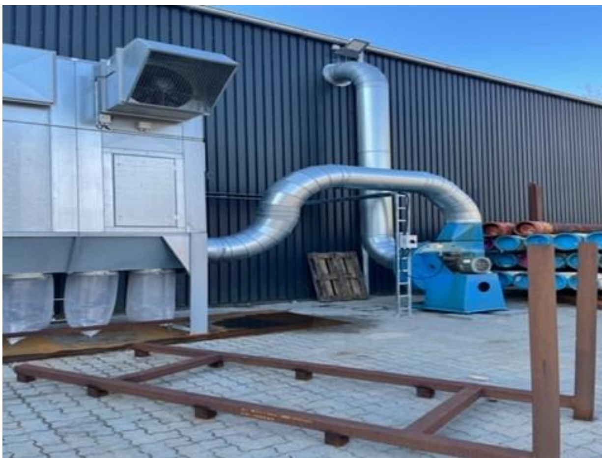
Figur 3: Afkast 2 fra hal 4, tilknyttet Aagaard filteranlæg.
