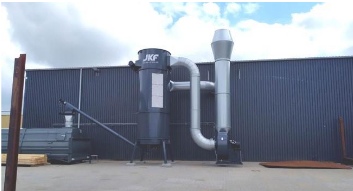
Figur 2: Afkast 1 fra hal 4, tilknyttet JKF filteranlæg.
