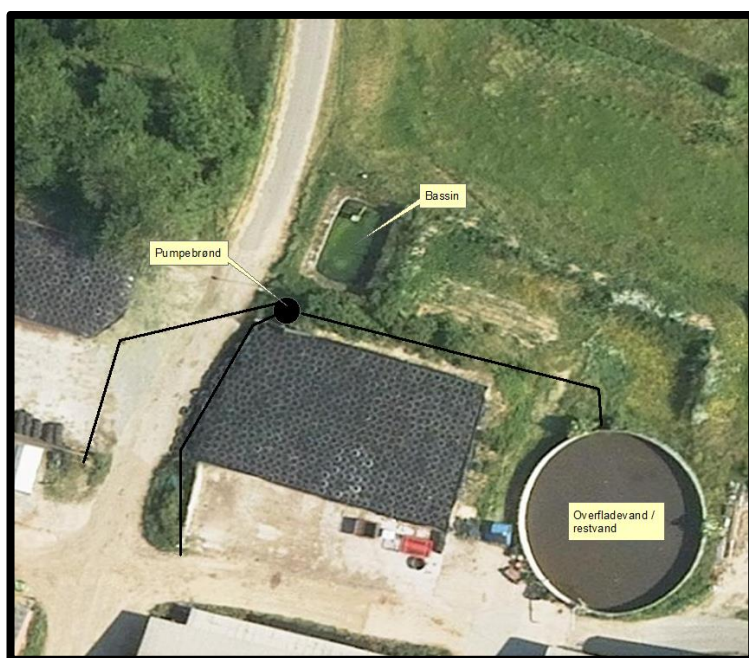
Figur 14. Opsamlingsbassin, som skal tages ud af brug, men som kan blive liggende udelukkende som en sikkerhedsforanstaltning.
