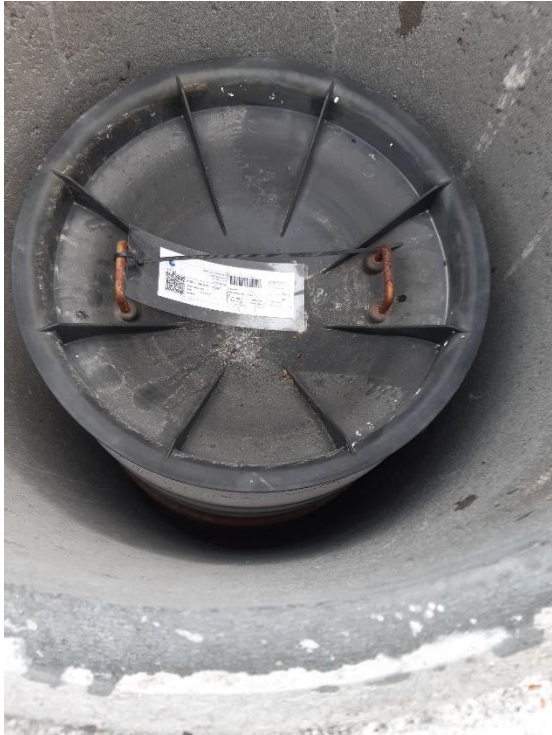
Foto 3. mærkning af brønd.
