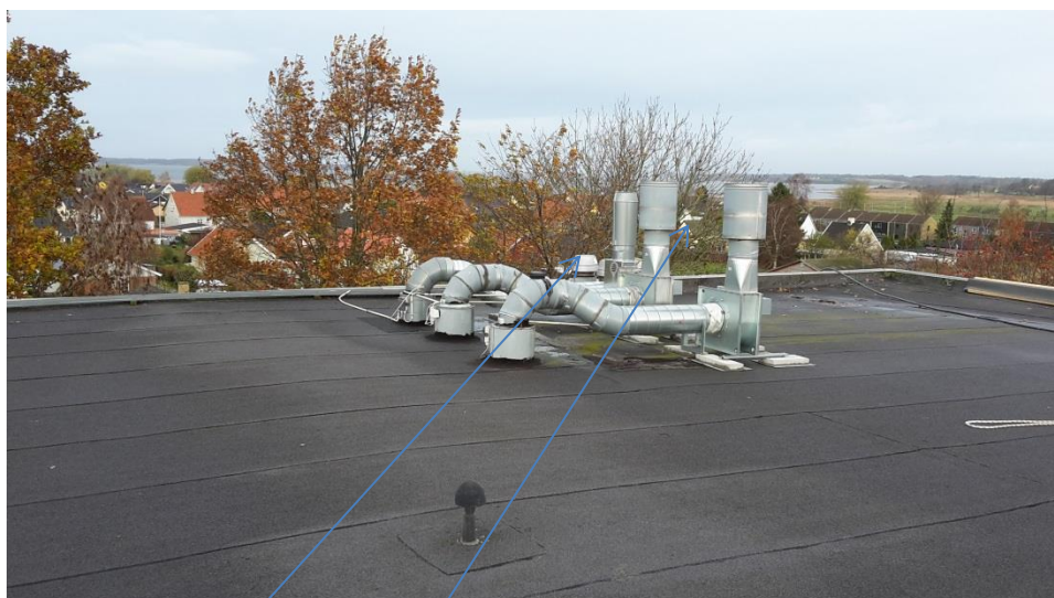
Afsugning laboratorier og stinkske
