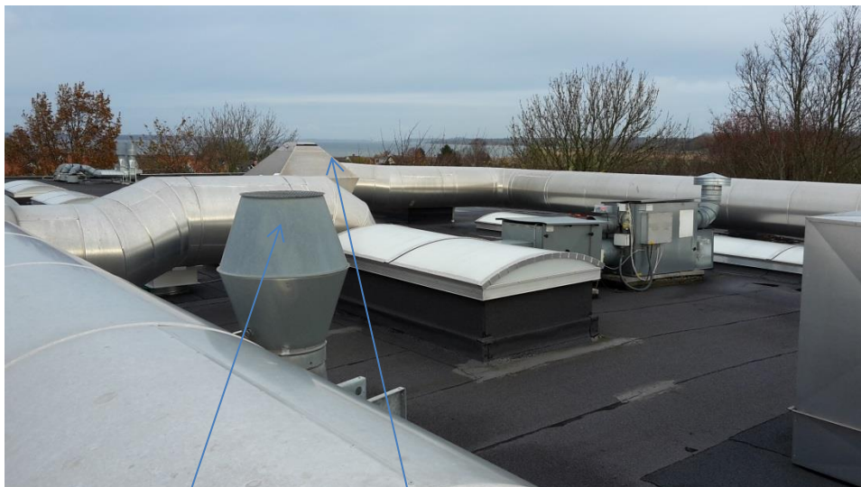
Afkast saponinrum og ventilationsafkast
