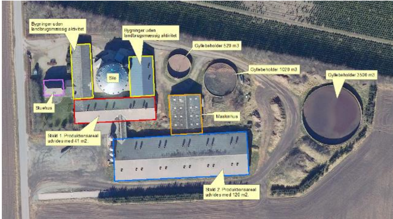
Figur 1. Oversigt over bygninger.
