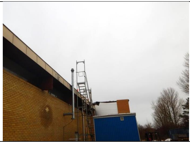
Foto 8: Afkast fra udsugningssystem.
