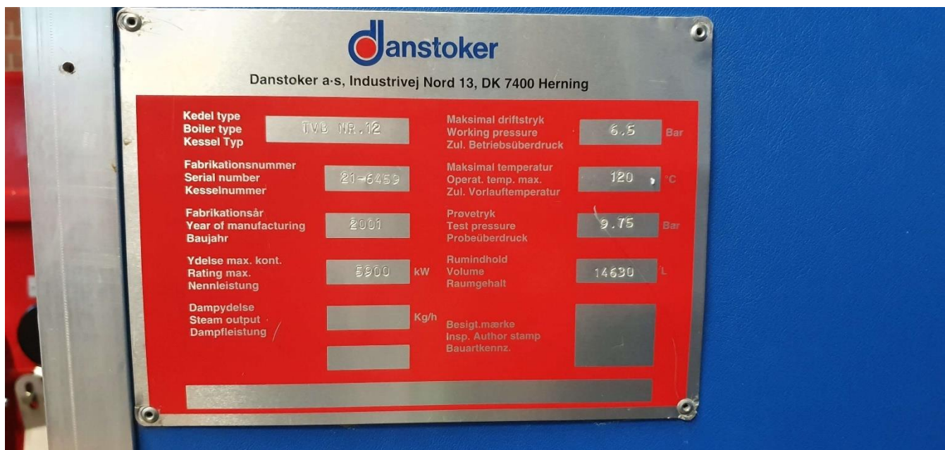
Kedel 2 - 5,9 MW fra 2001.
