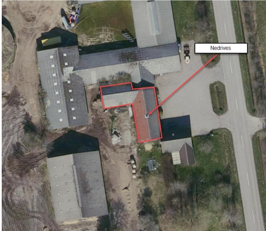
Figur 2. Bygninger som skal nedrives.
