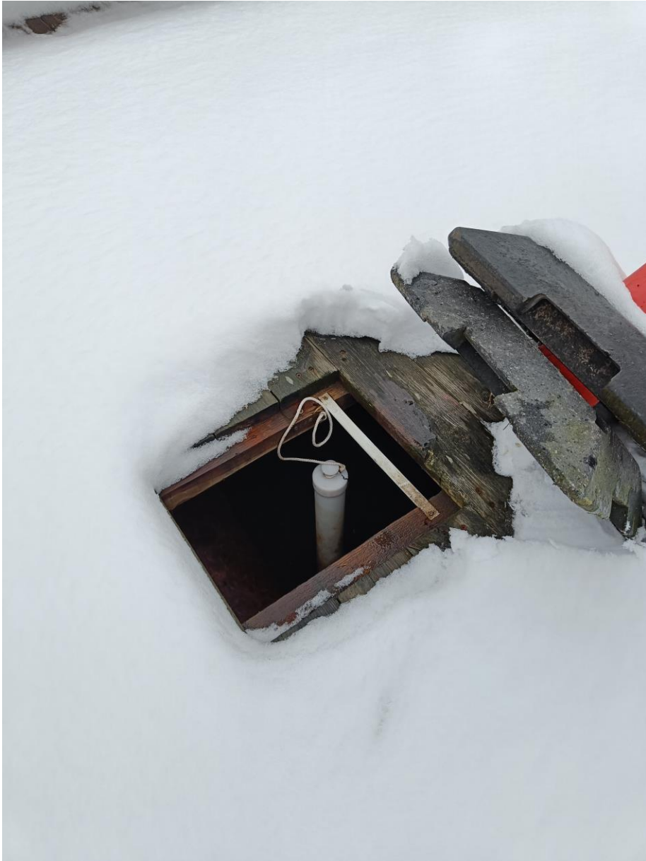
Billede 3.: Prøvebrønden under deponiets træbelægning.
