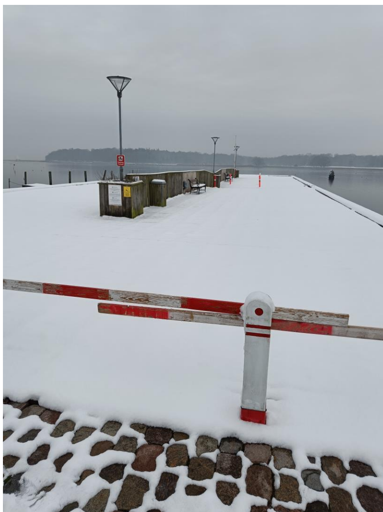
Billede 2.: Billede af snedækket deponi. Afspærring samt kegle markerer sætning.
