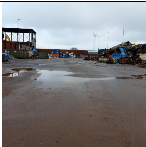
Ny tæt belægning med 5 års garanti.
