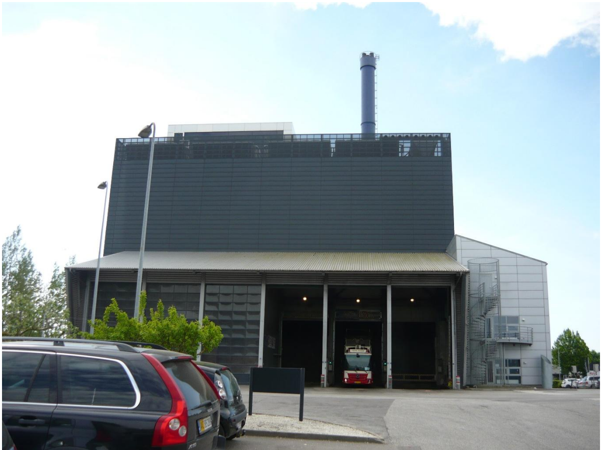
Figur 1: Porte til aflæssehal, tagkølere på tag af affaldssilo og skorsten i baggrunden
