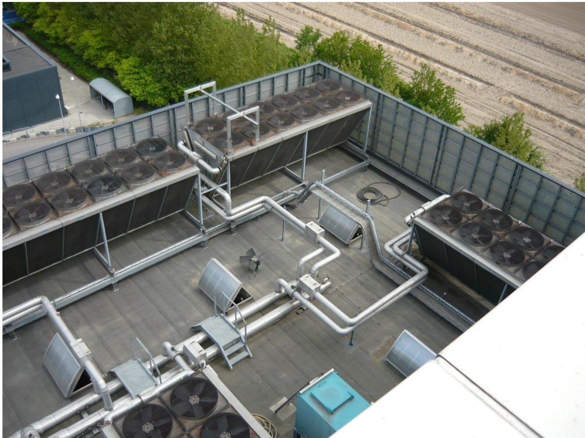
Figur 12: Tørkølere på tag af affaldssilo
