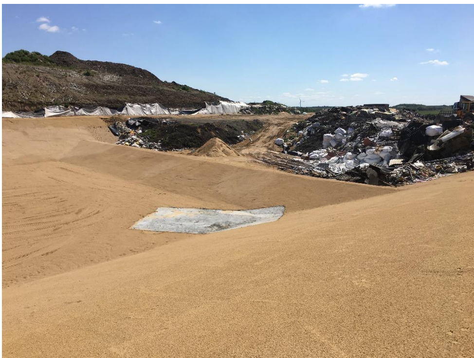
Figur 2: Den færdigetablerede enhed 9 fotograferet mod sydøst. Den høje del bagerst i billedet er enhed 5, mens enhed 10 er under opfyldning. Forrest i bunden af enhed 9 ses overside af udløbsbygværk for perkolatdræn.
