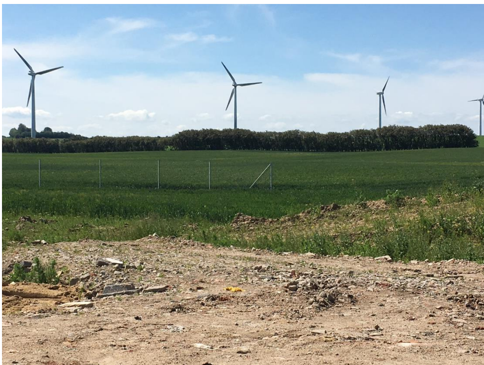
Figur 4: Foto taget fra det sydvestlige hjørne af enhed 10 i retning mod syd.
