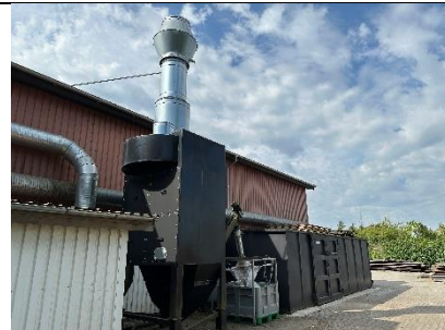
Bilag nr. 2: Nyt udsugningsanlæg
