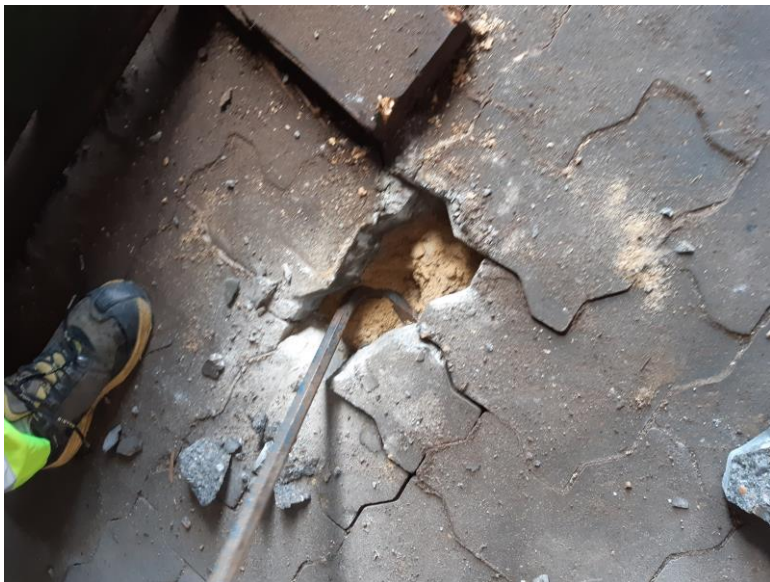
Figur 11 Der var en skarp frisk lugt af olie/diesel i sandet under belægningen.
