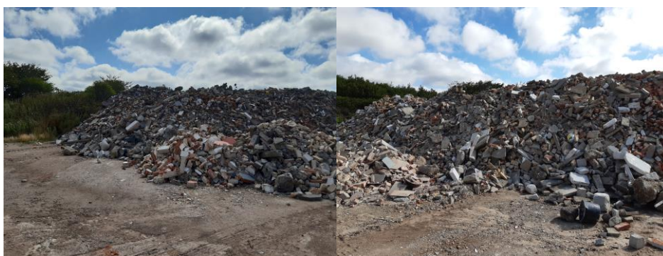
Figur 6 Oplag af bygge- og anlægsaffald til nedknusning.
