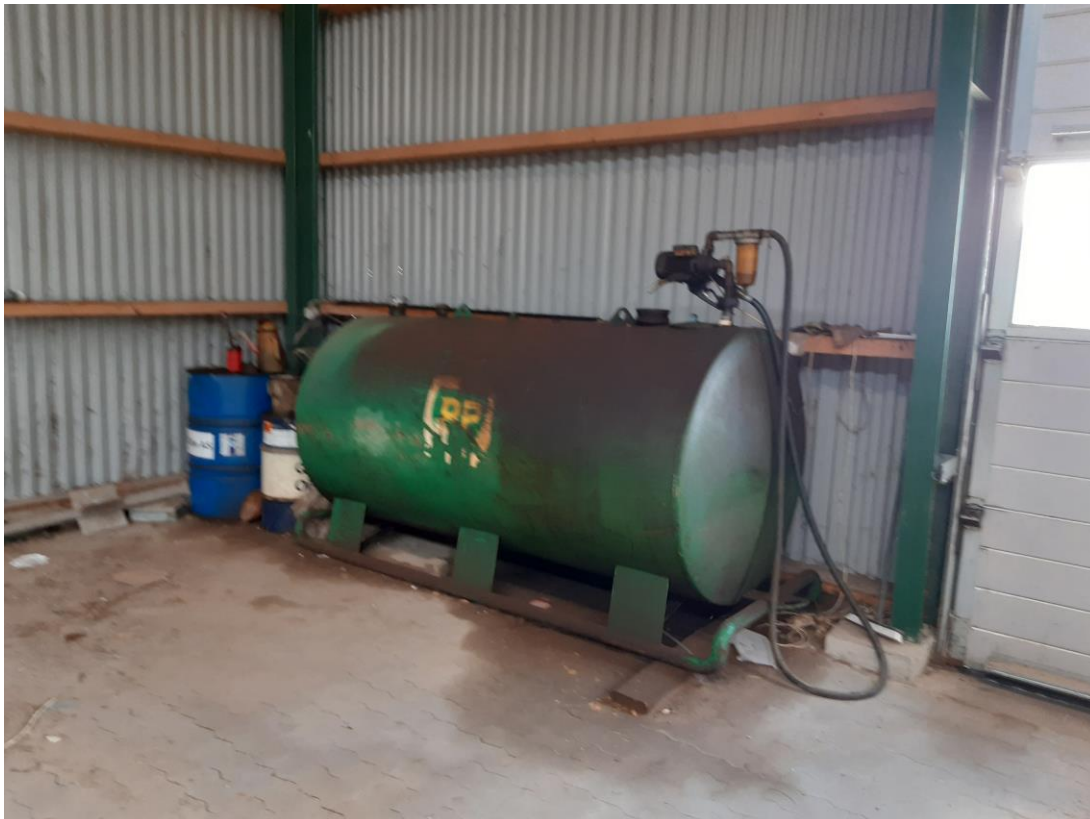
Figur 10 Spild omkring dieseltank.
