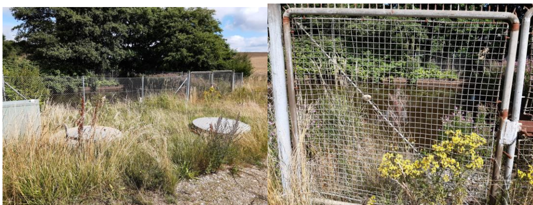
Figur 3 tv. Pumpebrønde til pumpning af perkolat til Tåbel Renseanlæg. Th. billede af perkolatbassin bag port.
