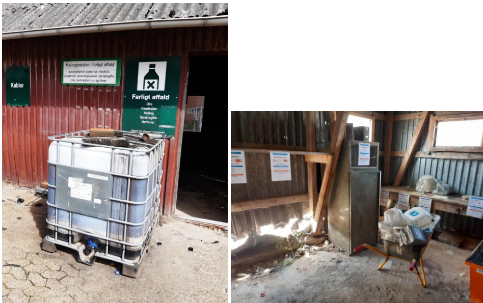
Figur 13 Tv. 1.000 L palletank med en form for olie. Th. del af hallen til farligt affald fra den nedlukkede genbrugsplads.
