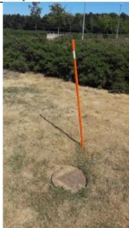
PB1 – monitoringsboring med vandtæt lukning og lås og lav beskyttelsesbrønd.
