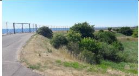
Lavningen længst mod syd hvor der ikke er deponeret. Aflåst hegn omkransende anlægget.
