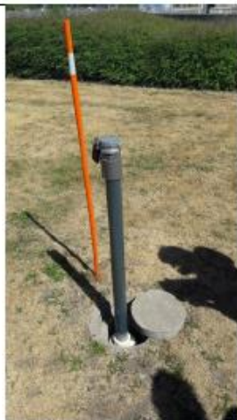
PB4 – monitoringsboring med vandtæt lukning og lås men uden beskyttelsesbrønd.
