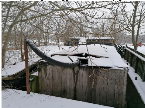
Modtagelse af olieholdigt spildevand til 30 m 3 aflæsningscontainer.
