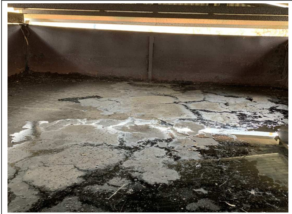
Stort brandslukningskar under overdækningen
