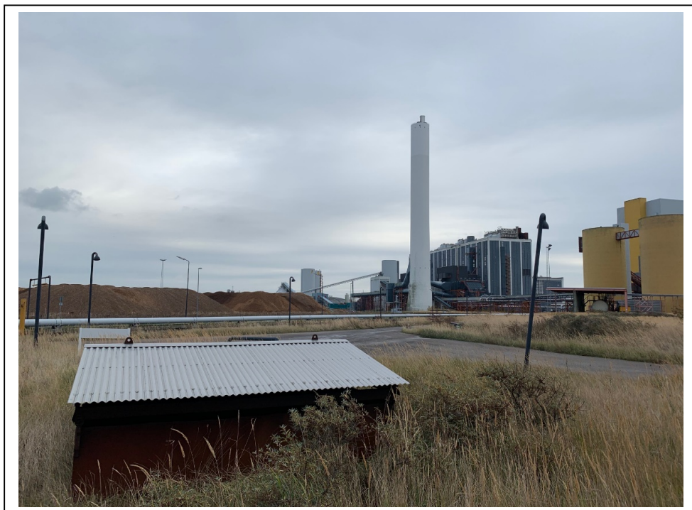
Stort overdækket brandslukningskar
