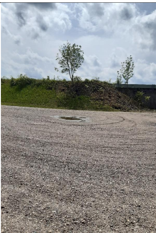
Tankgård og tankgårds mur/vold
