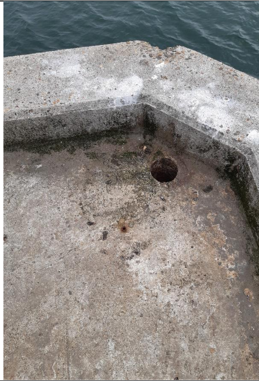
Opkant og spygat på pier
