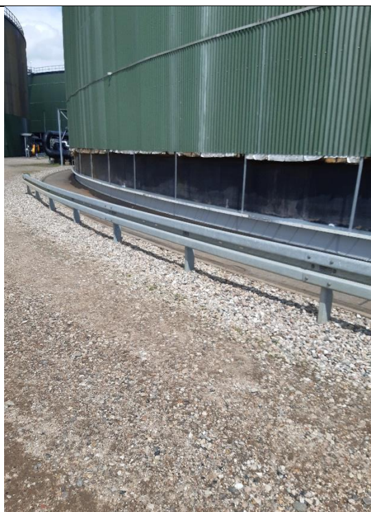
Tank M11, påkørselssikring og under renovering
