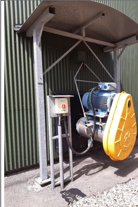
Tankmixer under tag med sladre-dræn under
