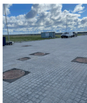
Fedtudskiller brønd og prøveudtagning
