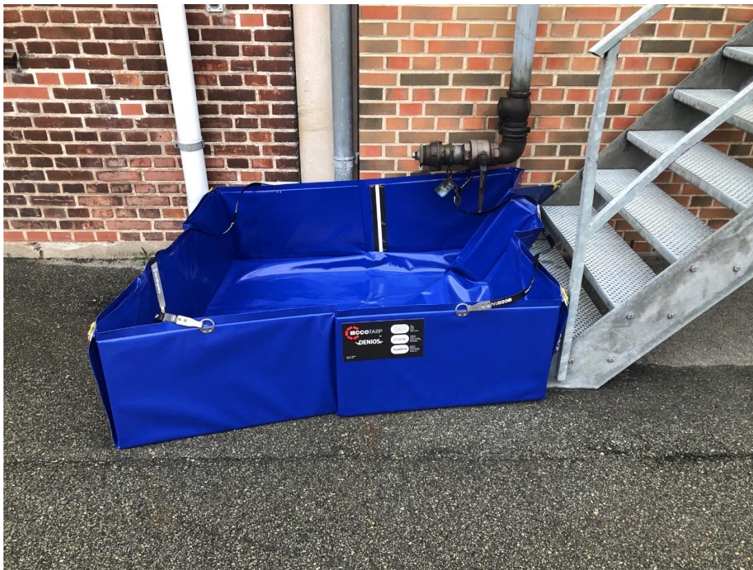
Opsamlingskar under påfyldestuds til olietank
