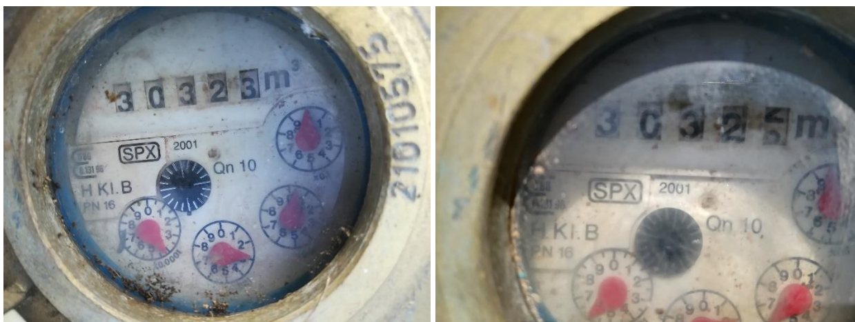
Billede 4 Måleren på perkolatpumpen tv. billede fra tilsyn d. 23. februar 2022 th. billede fra tilsyn d. 25. april 2019
