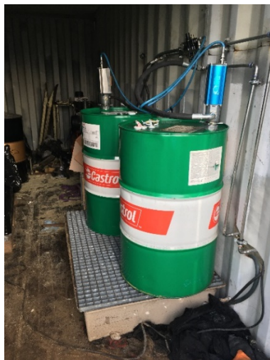
Oplag af motorolie med pumpe-system, spildsikrede i container.
