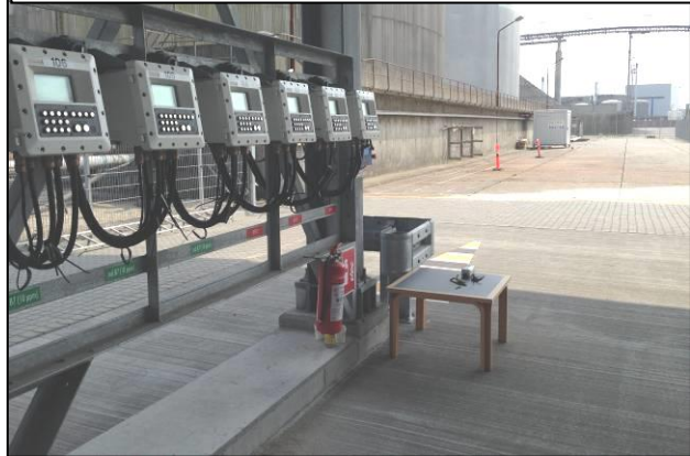
Foto af de små computere til styring af produktvalg og læssearme. I baggrunden ses styrehuset, hvor ankomst og banevalg meldes.
