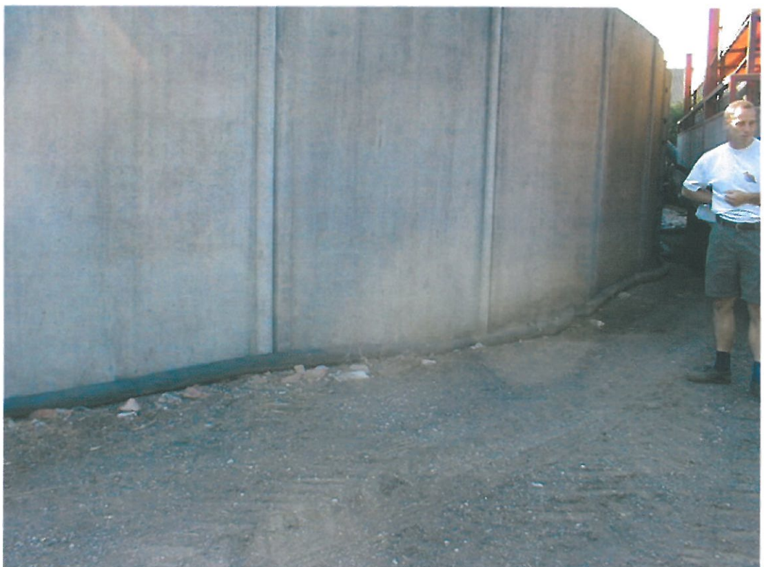
Flytbar pumpeledning til overførsel af gylle fra gyllebeholder til trykledning
