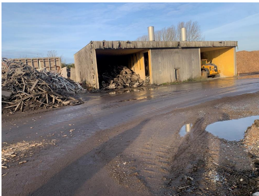
Asfalt brokker under tag.
