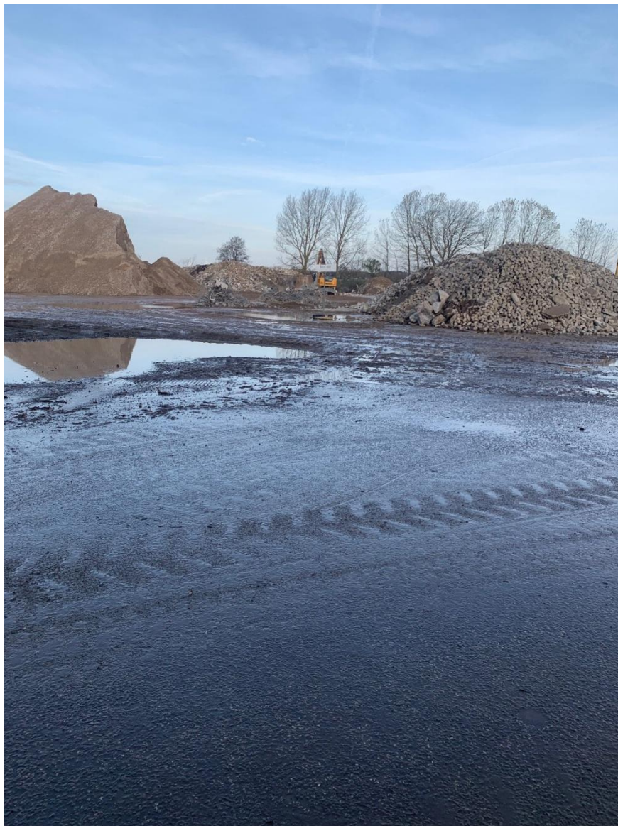
Oplag og behandling af knust beton
