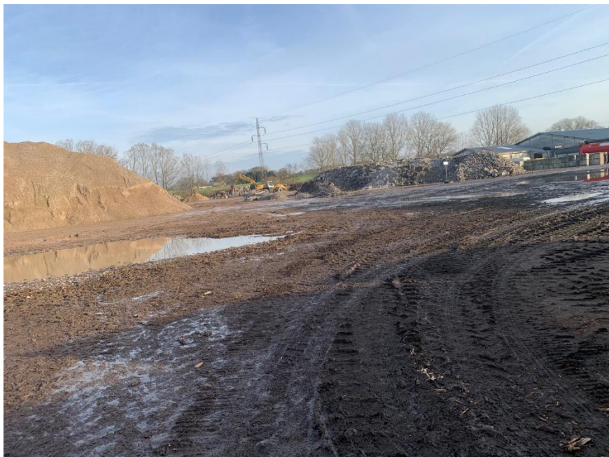
Oplag af knust beton
