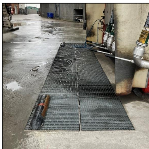
Udleveringssted, opstuvningskapacitet under risten, Oliehavnsvej
