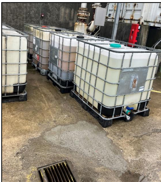
Palletanke med olie/vand ved afløb, Oliehavnsvej
