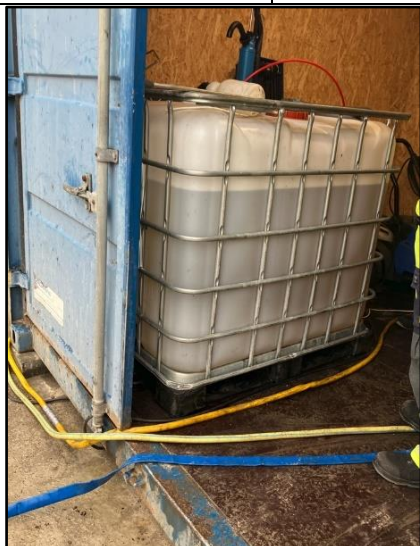
Sæbe i container, afløb umiddelbart udenfor, Oliehavnsvej
